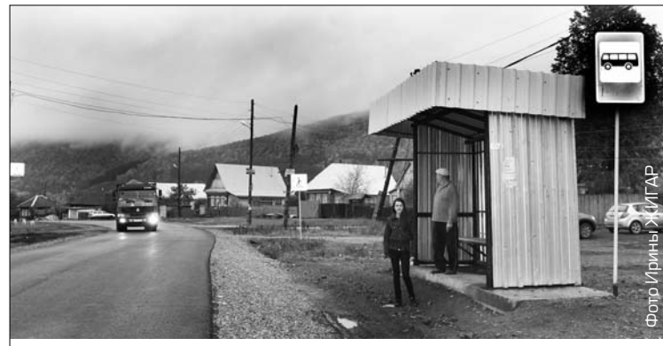
Новое асфальтовое покрытие дороги по ул. Энгельса в поселке Козинский
